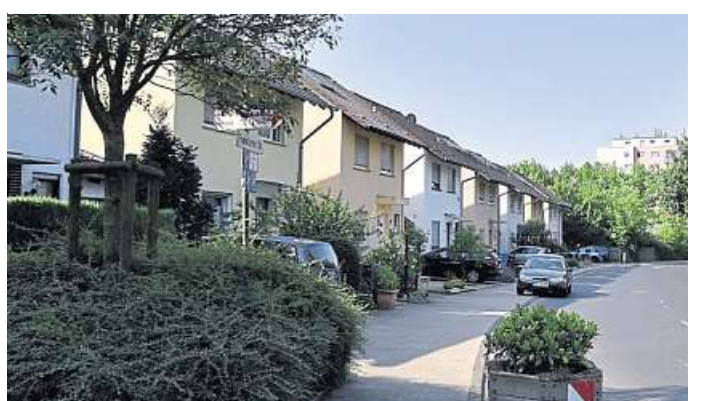
Die Frankfurter Straße begrenzt das Areal im Norden.
